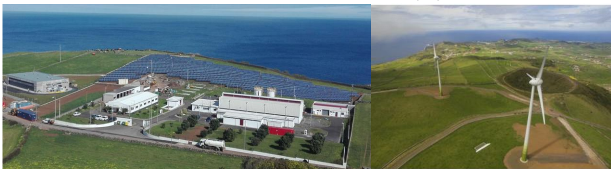
Figura 4.52_Infraestruturas de produção de energia elétrica no concelho de Santa Cruz da Graciosa (parque fotovoltaico, central termoeletrica, central de baterias e parque eólico
