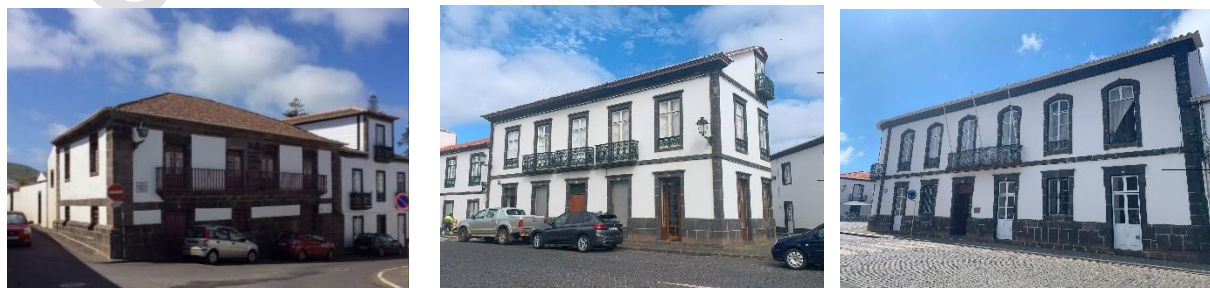
Figura 6.28_Exemplos de edifícios de Santa Cruz da Graciosa
