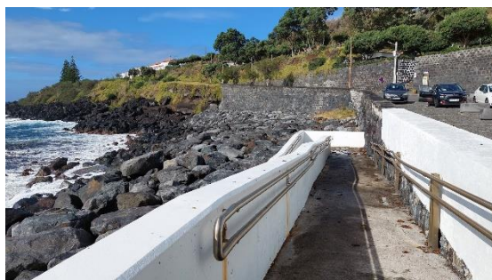
Muro longitudinal vertical com berma de proteção em enrocamento – Carapacho
