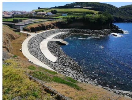
Obra aderente em enrocamento – Baía do Fanal [fonte: invest Angra]
