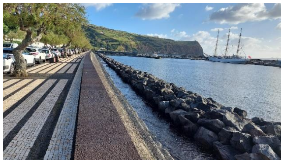
Muro longitudinal vertical com obra aderente em enrocamento destacada – Interior Porto da Horta
