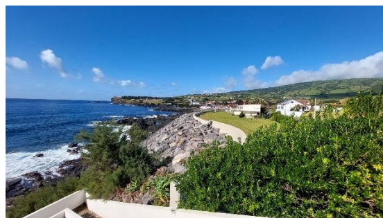
Obra aderente em enrocamento – Entre a Poça da Rainha e Porto da Feteira
