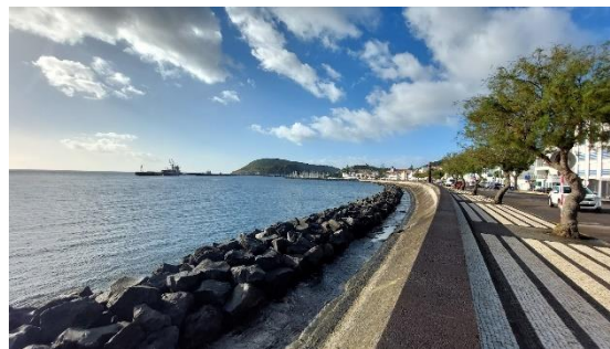
Muro longitudinal vertical com obra aderente em enrocamento destacada – Interior Porto da Horta
