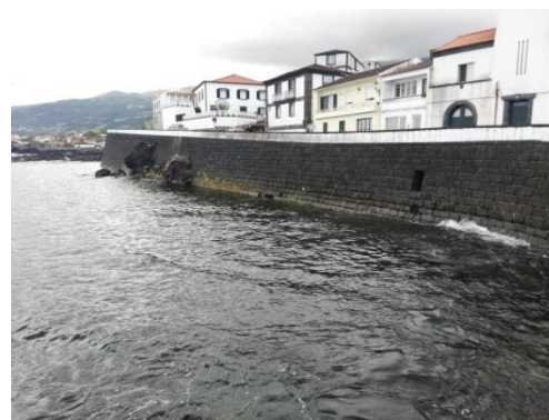
Muro longitudinal vertical – Estada Regional, Frente urbana de São Roque
