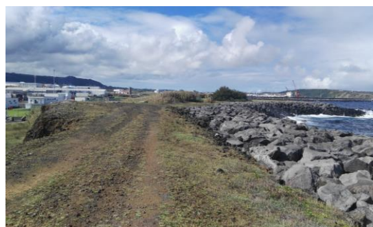
Obra aderente em enrocamento – Parque de combustíveis, Praia da Vitória
