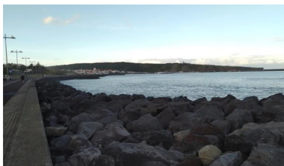
Campo de esporões e obra aderente em enrocamento – Marginal da Praia da Vitória
