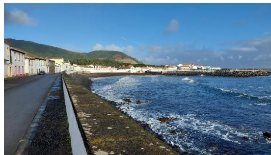
Muro longitudinal vertical com berma de proteção em enrocamento – Praia
